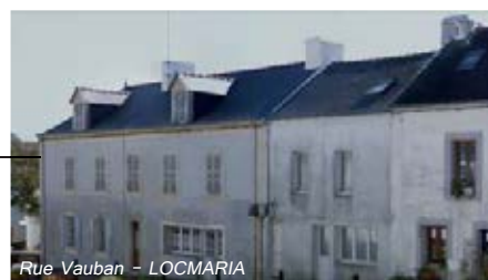
Rue Vauban - LOCMARIA
