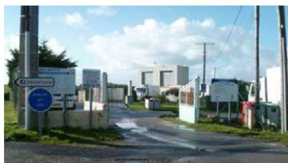
- Entrée du site ISDND -
