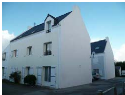
- Logements collectifs à Locmaria -
